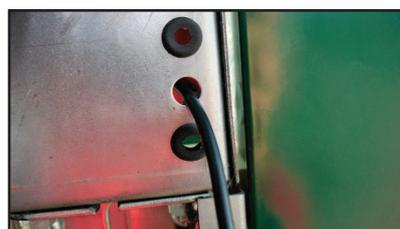
4. Проложить провод с разъемом для приемника (черный) к отверстию для фотозлемента ( в боковой стойке с мотором)
