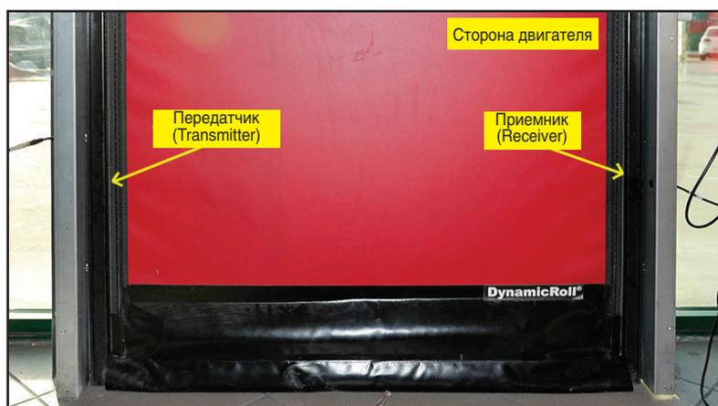
5. Завести концы проводов фотоэлементов в боковые стойки. Подключить фотоэлементы к проводам для фотоэлементов. Зафиксировать корпус фотоэлемента в боковой стойке.
